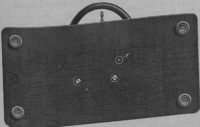
Um das Werk der Maschine auf dem Transport vor Beschädigungen zu schützen, ist an der Unterseite der Sockelplatte bei S eine Schraube angebracht. Nach Ankunft ist diese Schraube sofort zu entfernen (jedenfalls vor irgendeiner Kurbeldrehung) und der durch sie vorher festgehaltene Schlitten Sh etwas nach links zu verschieben, bis die Taste T hörbar einfällt.
